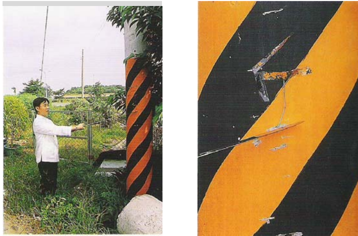
Abb. 7: Überprüfung der Klingenhärte an Betonsäulen
